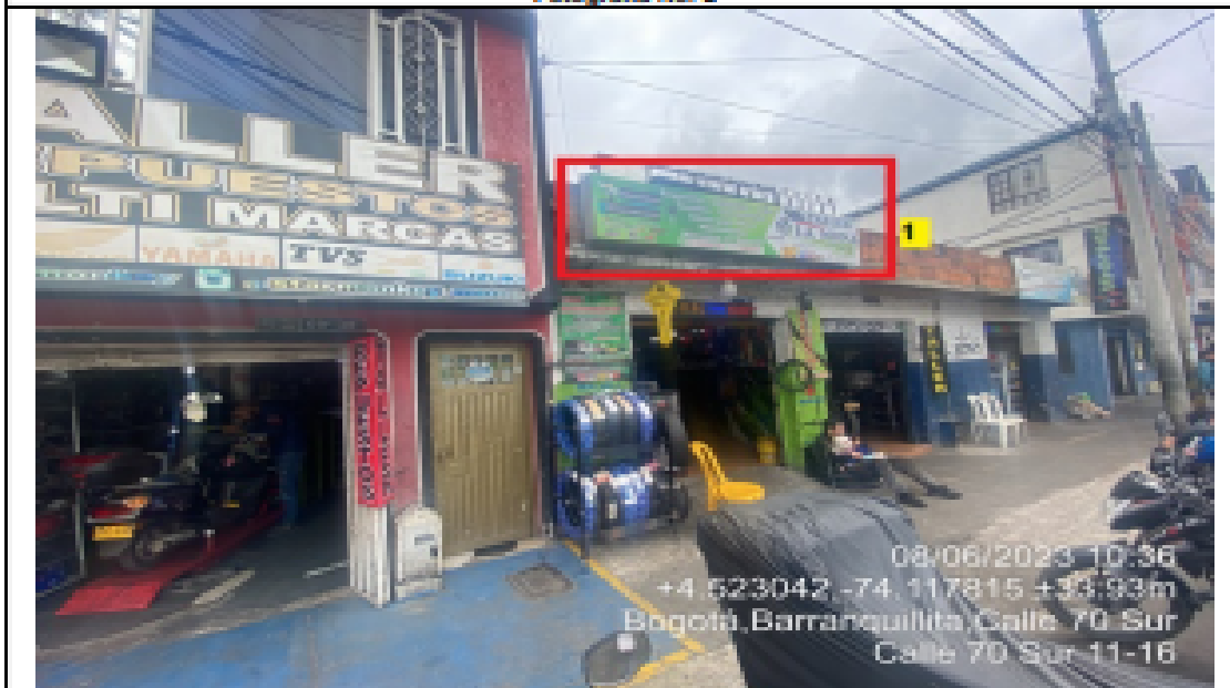
En la cual se evidencia la fachada del establecimiento comercial TALLER REPUESTOS Y MONTALLANTAS LOS SUIZOS, en la que se observa: un (1) elemento publicitario identificado con el número 1, el cual al momento de la visita no contaba con el registro ante la SDA.
